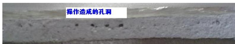
图 20-3 层间不光滑造成操作孔洞示意
