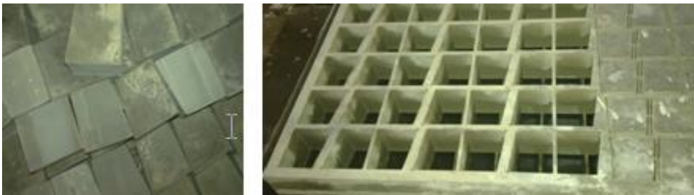
图 2-5 水刀切割不合理，应设置型材切割
